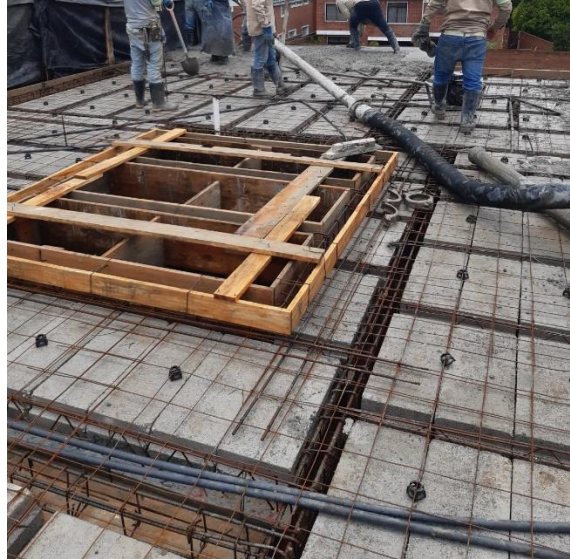
Figura 32. Fotografía de fundición de losa de segundo piso
