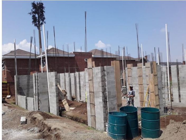
Figura 25. Fotografía de construcción de elementos verticales de primer nivel
