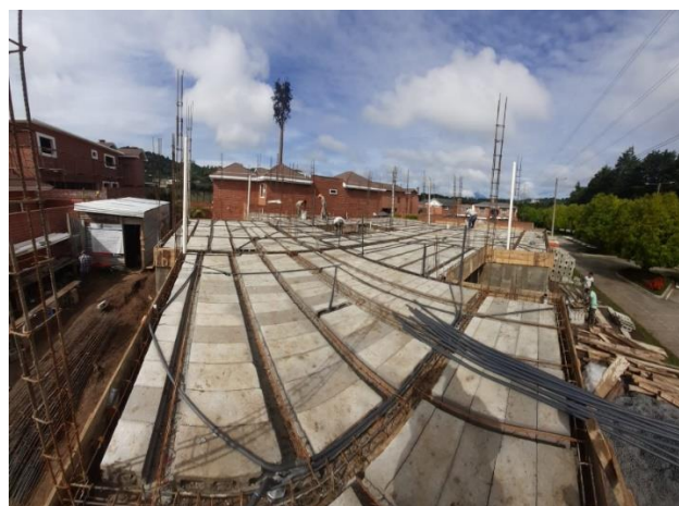
Figura 26. Fotografía de losa de primer nivel
