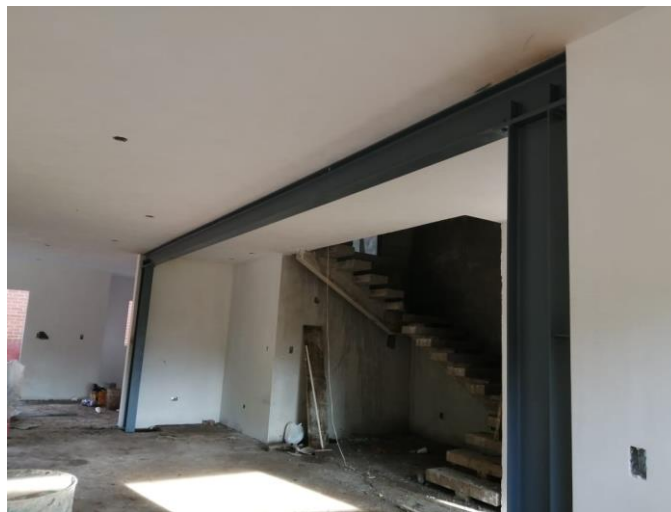
Figura 33. Colocación de viga de acero para refuerzo de eje 5
