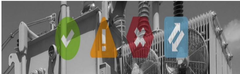
Figura 15. Simbología utilizada en un resumen de análisis de aceite dieléctrico de un equipo eléctrico
