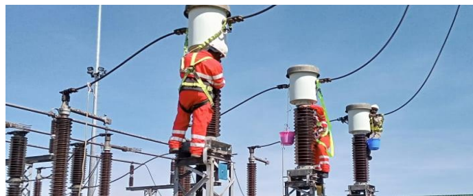
Figura 11. Limpieza de aislamiento para prevenir descargas por contaminación
