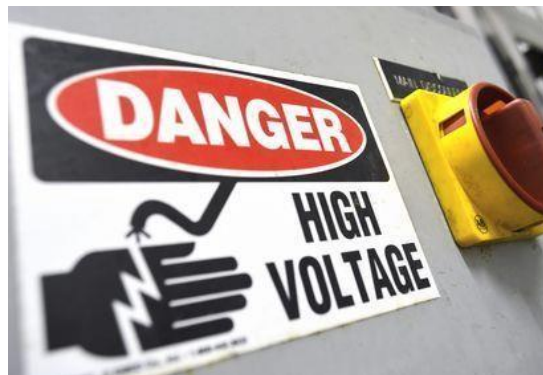
Figura 22. Rotulación sobre riesgos a la seguridad es subestación
