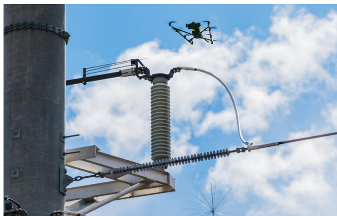
Figura 17. Inspección de subestaciones por dron
