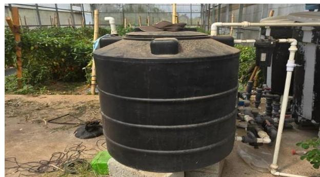
*Nota.* Tanque de almacenamiento de agua proveniente del pozo tipo pileta. Elaboración propia.
