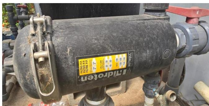
*Nota.* Filtro de agua para pozos, utilizado en sistemas de riego por goteo para evitar obstrucciones. Elaboración propia.
