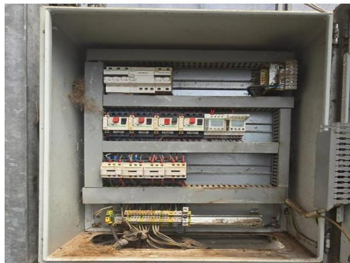
*Nota.* Tablero de contactores, funcional pero falto de mantenimiento. Elaboración propia.
