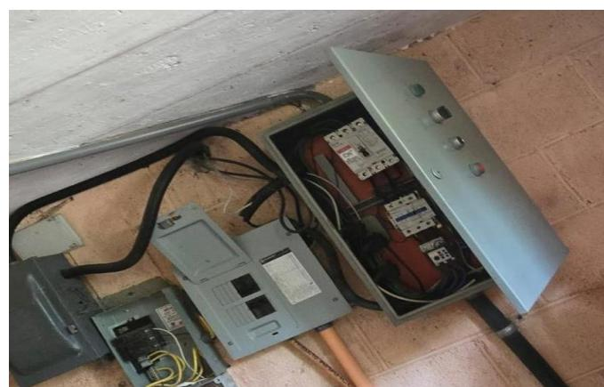
*Nota.* Tablero de distribución primario ubicado dentro de una caseta de concreto. Elaboración propia.
