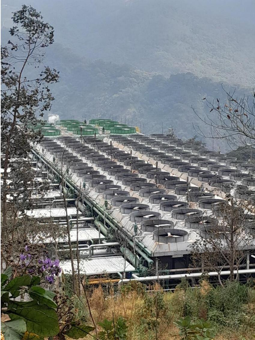
*Nota.* Parte superior de la planta, se pueden observar los ventiladores que conforman el condensador. Elaboración propia.
