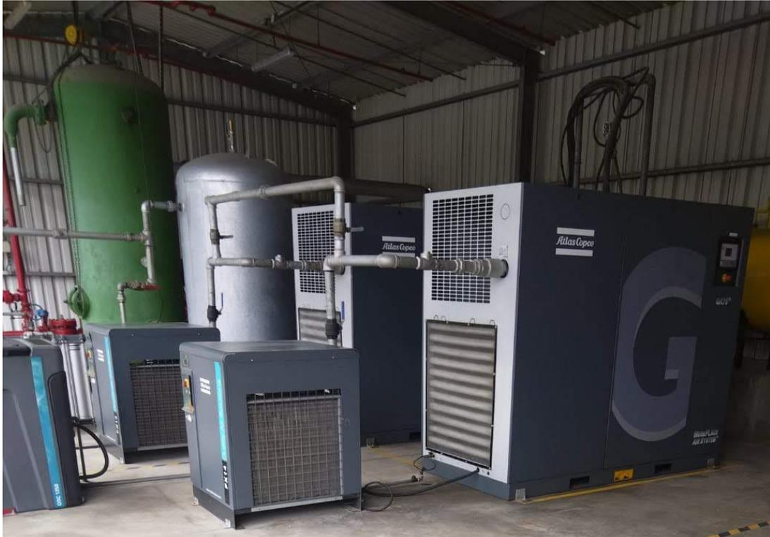
*Nota.* Área de sistema de aire comprimido, a la vista 2 compresores Atlas, dos secadoras y tanque de almacenamiento. Elaboración propia.
