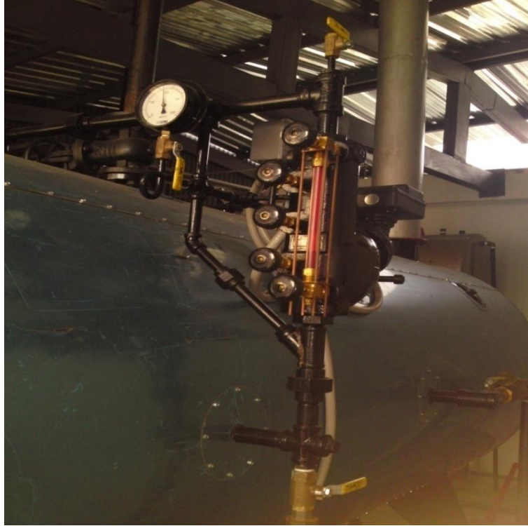
Figura 4. Medidor de nivel en la planta cosmética
