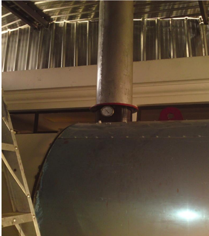
Figura 3. Chimenea en la planta cosmética
