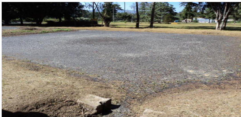
Figura 25. Laguna de estabilización secundaria anaerobia
