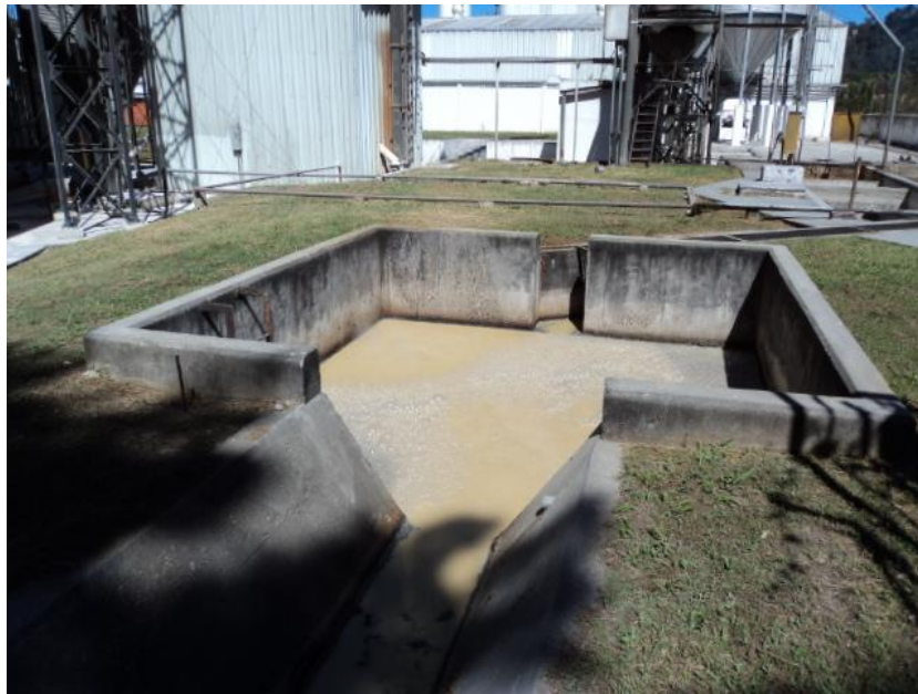
Figura 22. Fosa de sedimentación secundaria
