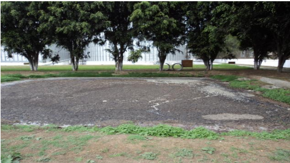
Figura 39. Colocación de revestimiento de concreto en los taludes de la primera laguna
