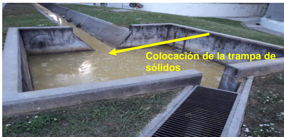
Figura 37. Colocación de la trampa de sólidos en la parte final
