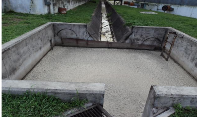
Figura 16. Fosa de sedimentación secundaria, nueva etapa de separación de sólidos gruesos
