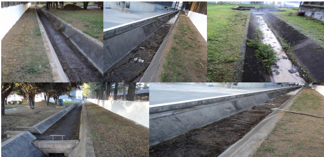
Figura 23. Canal trapezoidal, problemas de maleza y material flotante
