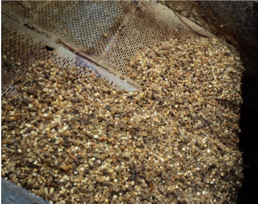
Figura 47. Acumulación de sólidos en el tamizador
