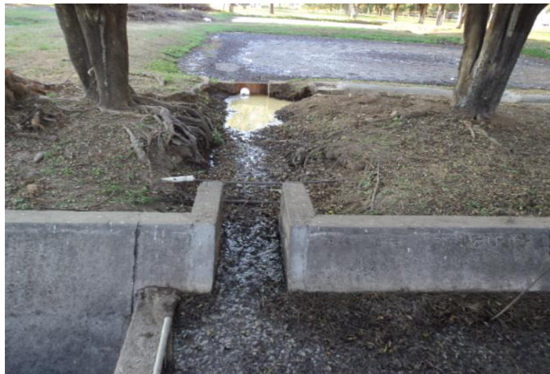
Figura 30. Entrada del agua residual a la primera laguna
