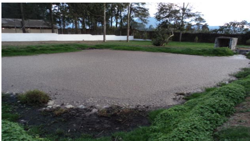
Figura 43. Colocación de revestimiento de concreto en los taludes de la quinta laguna
