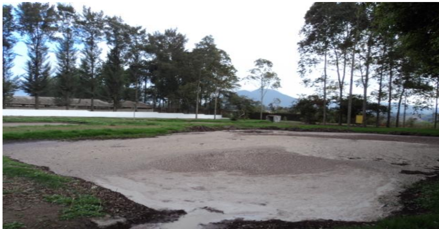
Figura 41. Colocación de revestimiento de concreto en los taludes de la tercera laguna
