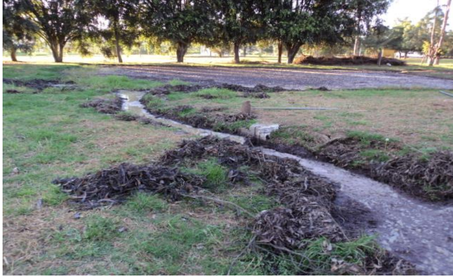
Figura 33. Interconexión de la tercera a la cuarta laguna
