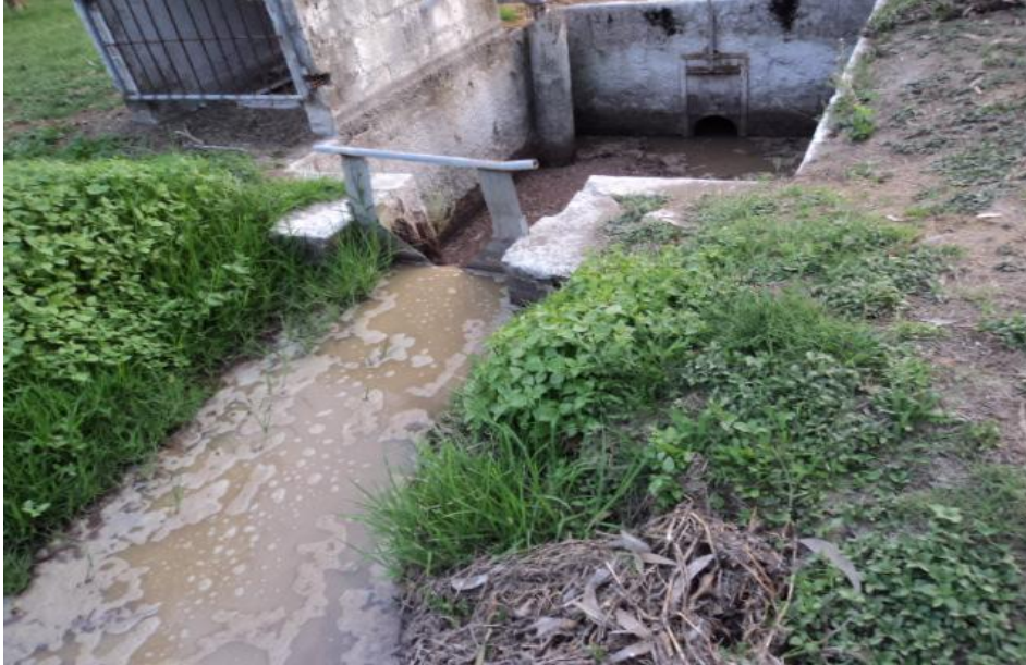
Figura 35. Salida del agua residual en la última laguna
