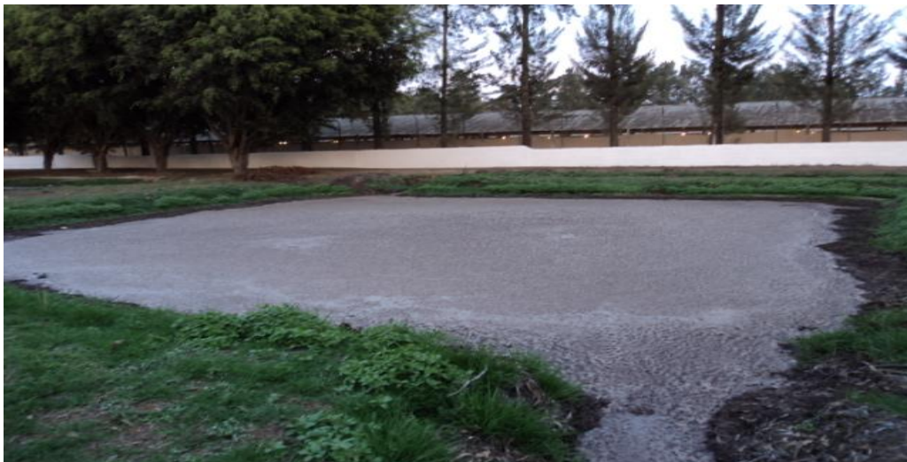
Figura 27. Presentación física de la laguna de estabilización cuaternaria
