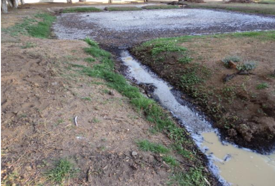
Figura 31. Interconexión de la primera a la segunda laguna
