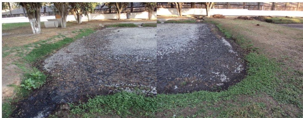
Figura 24. Primera laguna de estabilización anaerobia
