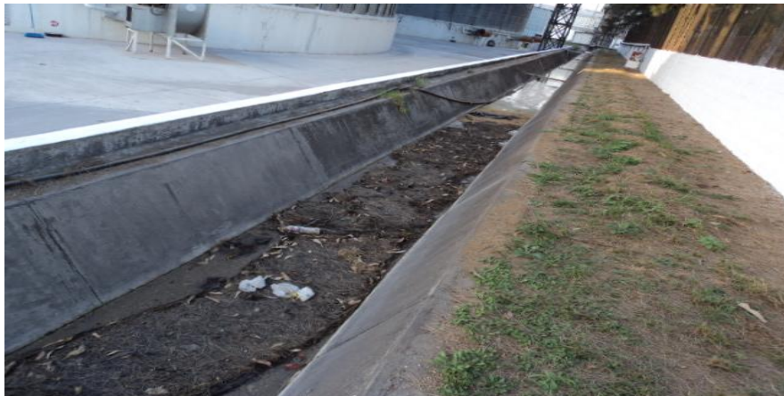
Figura 48. Material flotante en el canal trapezoidal
