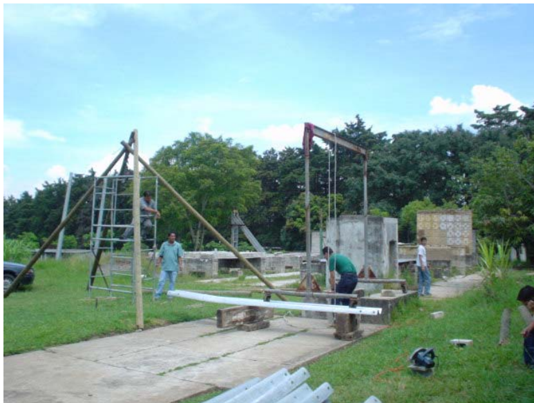
Figura 3. Fotografía de las instalaciones de ensayo de la sección de Tecnología de Materiales y Sistemas Constructivos
