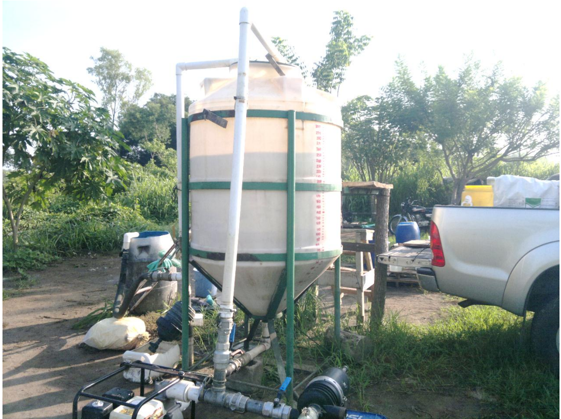
Figura 4.3. Tanque de mezcla utilizado en el lugar de aplicación
