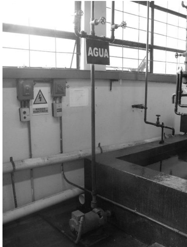
Figura 19. Suministro de agua
