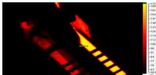
Figura 42. Tubería de alimentación de vapor y de retorno de condensados sin aislante
