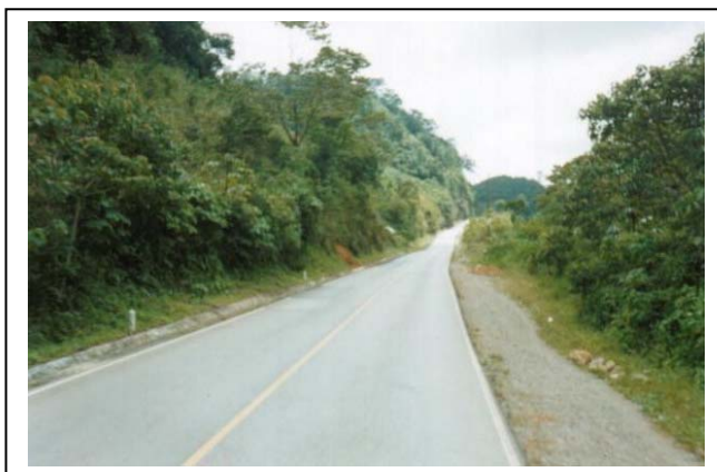
Figura 5. Carretera San Juan Chamelco
