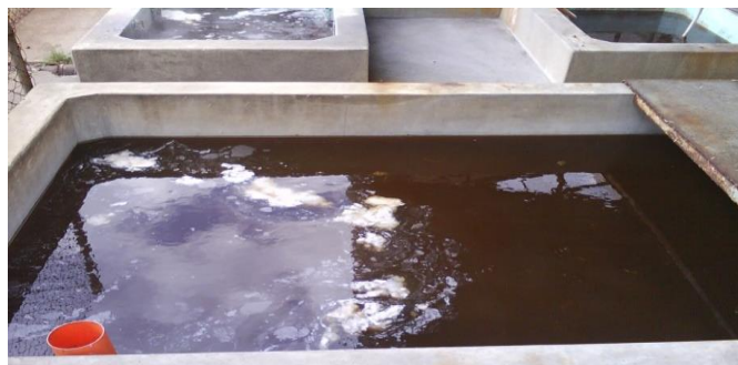
Figura 5. Sistema de pilas por rebalse donde desemboca el efluente de cada uno de los pasos del lavado del algodón
