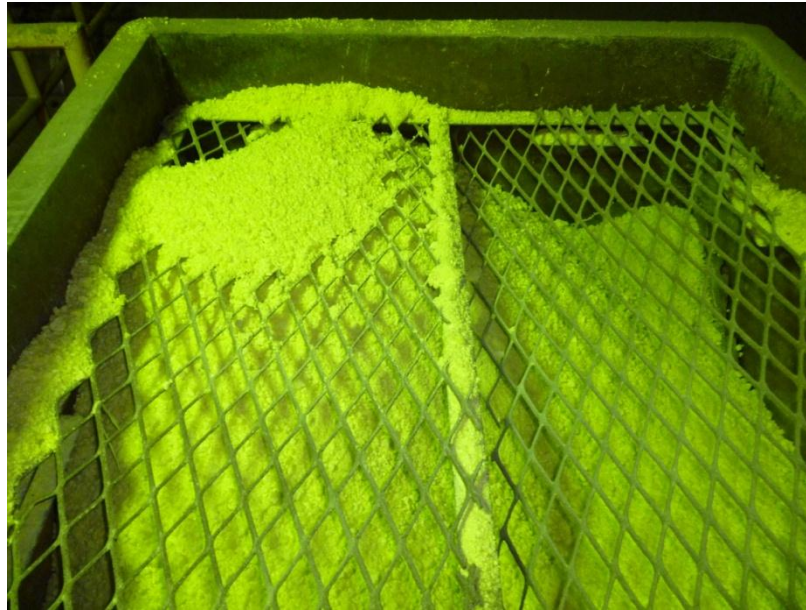
Figura 16. Azufre elemental en polvo entrando a la tolva del horno de quemado
