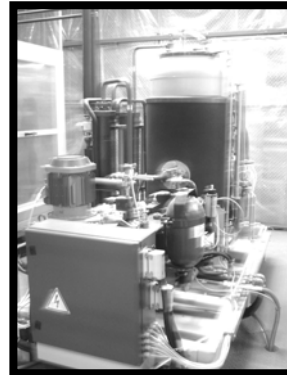
Tanque de isocianato
