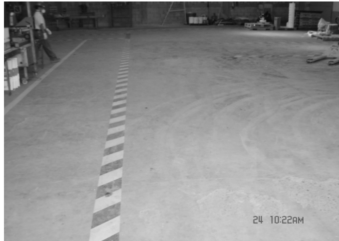
Figura 12. Delimitado de piso
