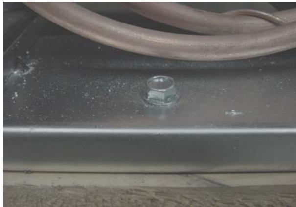
Figura 19. Anclaje del equipo con la tarima
