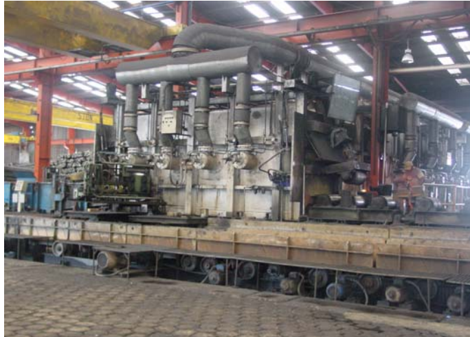
Figura 5. Horno vista interior de la planta
