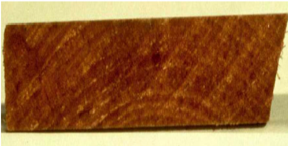
Figura 13. Grietas en extremos no visibles
