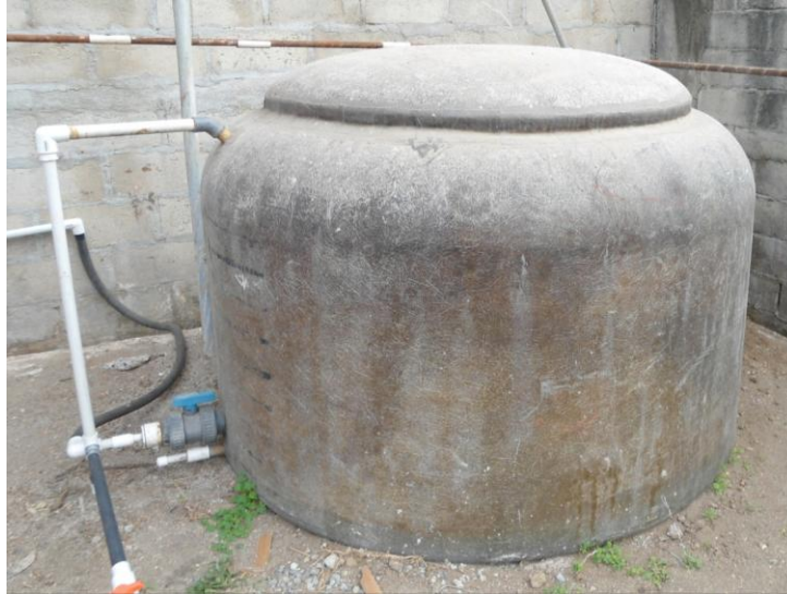
Figura 17. Desulfurizador
