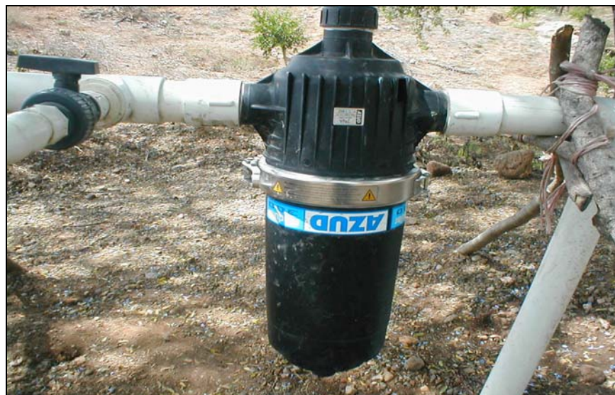
Figura 20. Filtro Azud del tipo T
