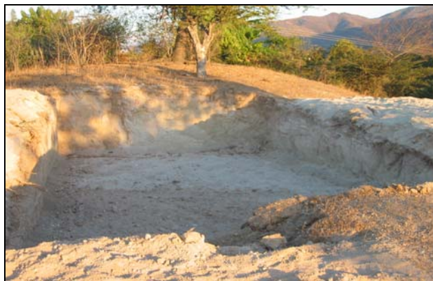
Figura 19. Construcción del tanque reservorio
