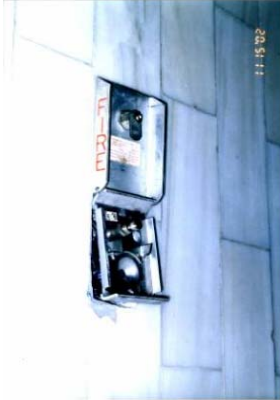
Figura 26. Alarma inservible
