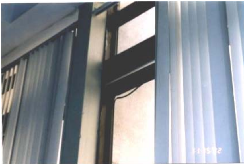
Figura 29. Empaques de ventanales defectuosos.
