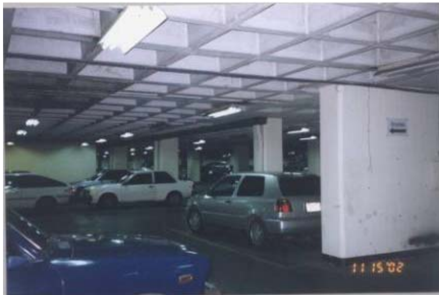
Figura 25. Hacinamiento de vehículos en el sótano 2.
