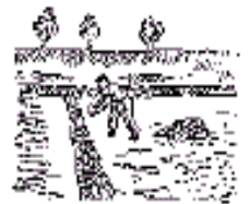
7. Construcción de drenajes internos.
