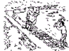
5. Construcción del drenaje periférico.
