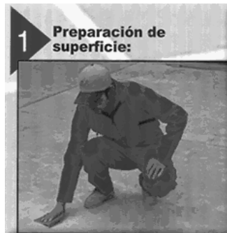
Figura 43. Reparación de suelos o pisos de Fuller
