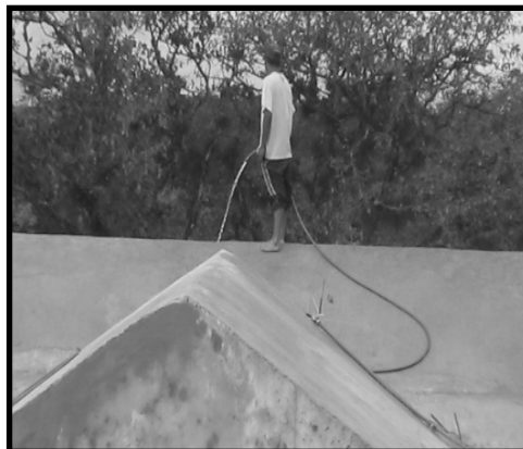
Figura 35. Realización de prueba de impermeabilización
