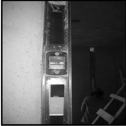
Figura 31. Verificación de nivelación
