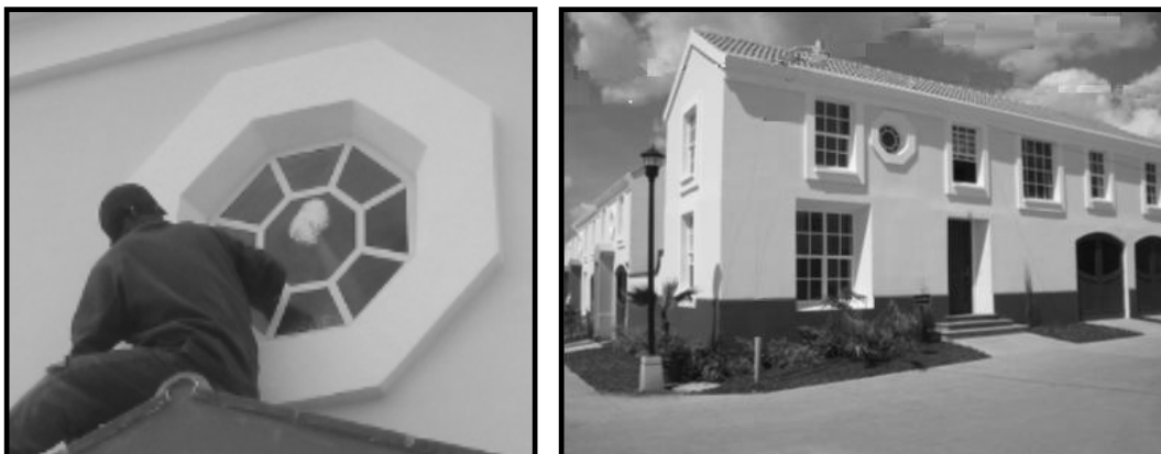
Figura 41. Limpieza final de vivienda
