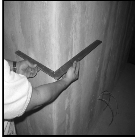
Figura 32. Verificación de escuadras
