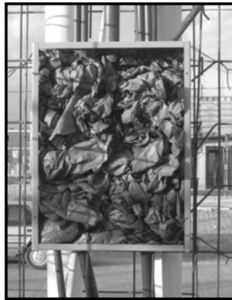
Figura 58. Bolsa de cemento reutilizada para tapar cajas eléctricas
