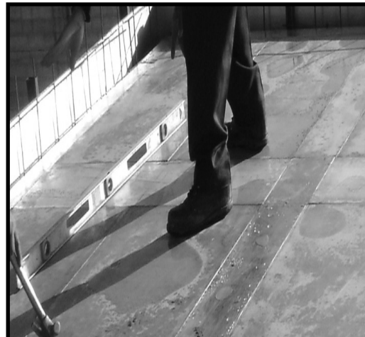
Figura 29. Medición de formaletas con plomo Figura 30. Medición de formaleta con nivel
