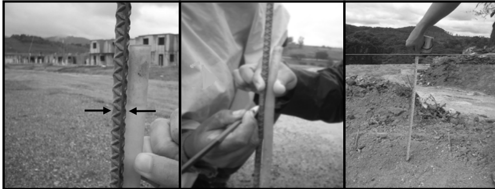
Figura 18. Etapas de la prueba de nivelación con manguera
