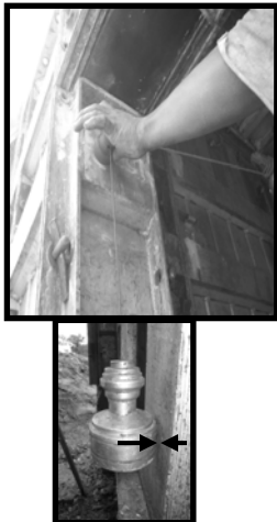
Figura 29. Medición de formaletas con plomo Figura 30. Medición de formaleta con nivel
