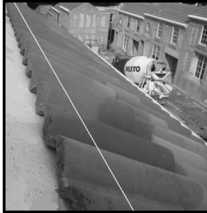
Figura 37. Tejas alineadas correctamente
