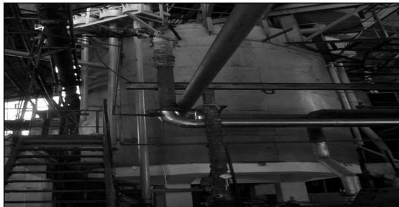
Figura 7. Clarificador de jugo
