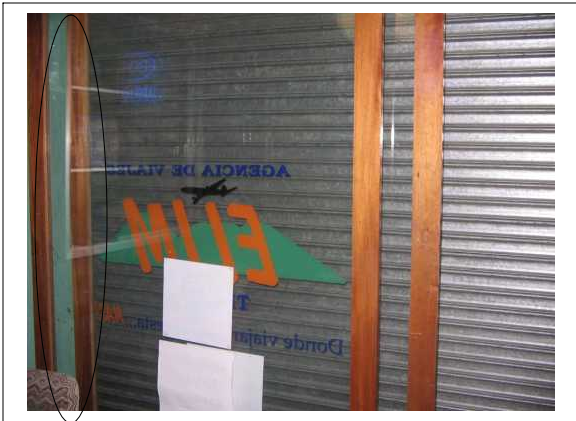
Figura 31. Vista de remodelaciones leves que tendrán que ser tomadas en las instalaciones.
