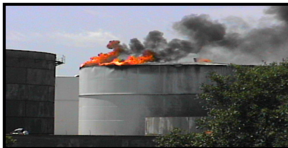
Figura 15. Fábrica de almacenamiento de combustible
