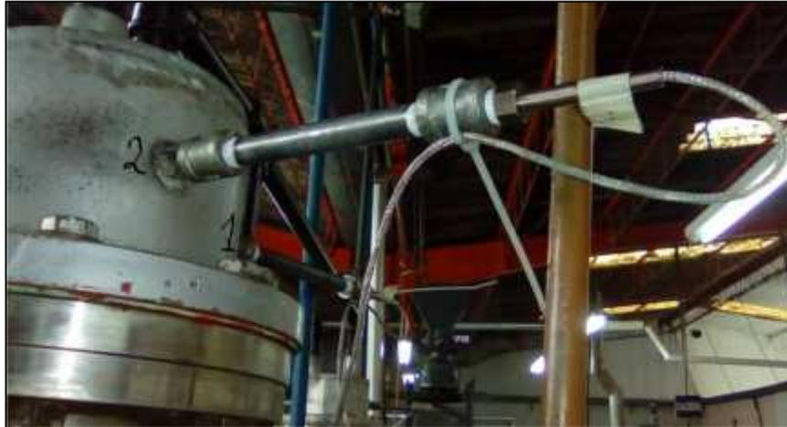
Sensores RTD 3 y 4 instalados al cabezal del ICCT2, sensor RTD 6 en lado de descarga del agua de circulación de la coraza del ICCT2.
