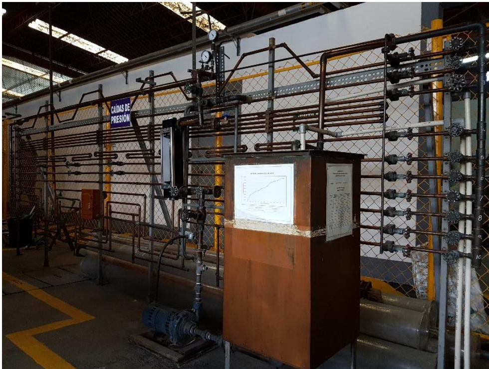
Figura 3. Equipo de caídas de presión
