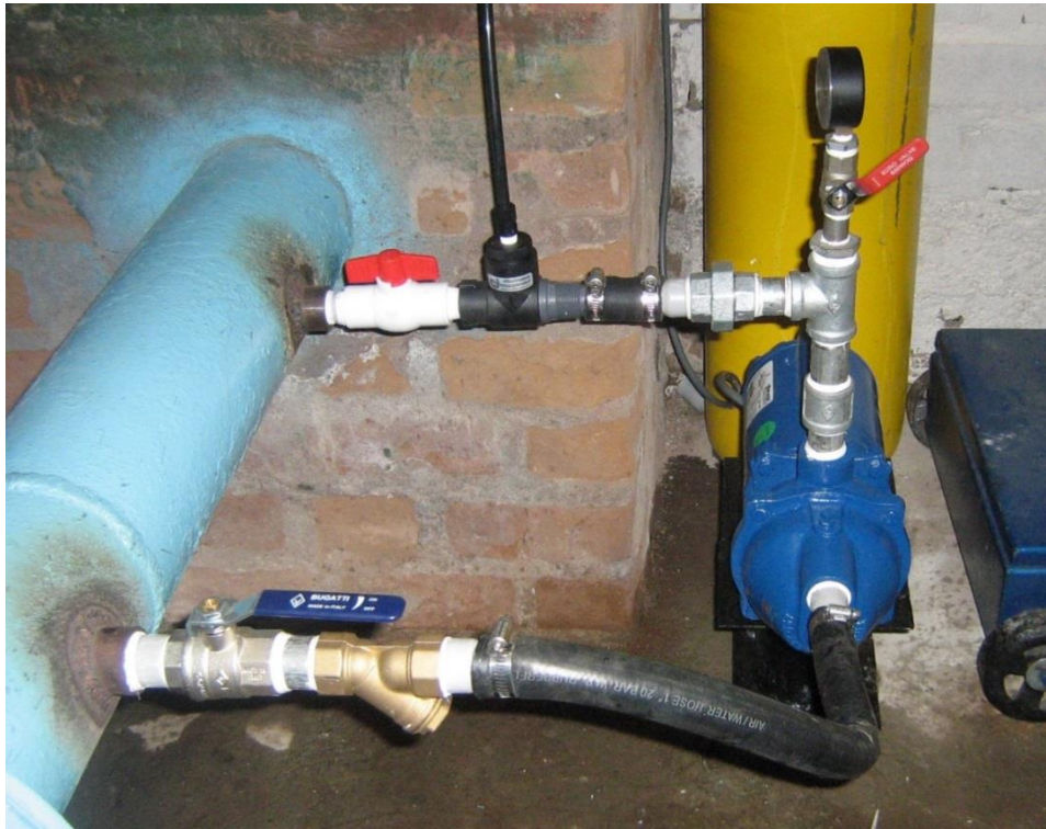
Figura 1. Sistema cloro gaseoso
