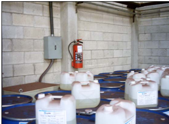
Figura 36. Falta de señalización en la bodega de materia prima.
