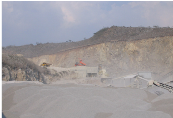
Figura 13. Pulverización de agregados
