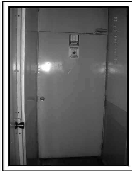
Figura 4. Ejemplo de las puertas que están en la empresa.
