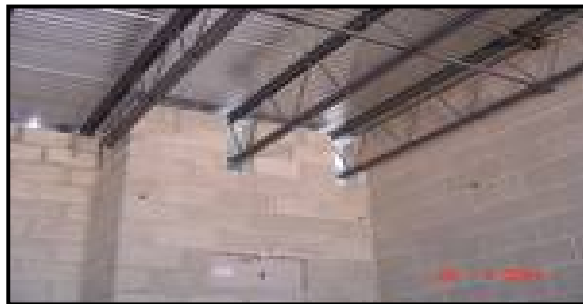
Figura 3. Techo y armazón
