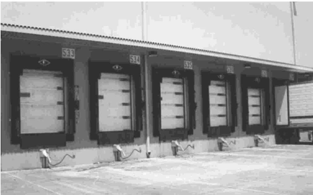
Figura 21. Rampa de recepción cerrada
