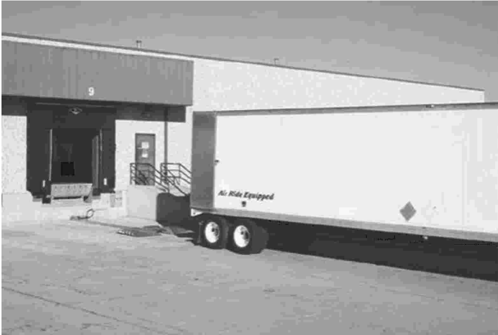
Figura 20. Rampa de recepción abierta
