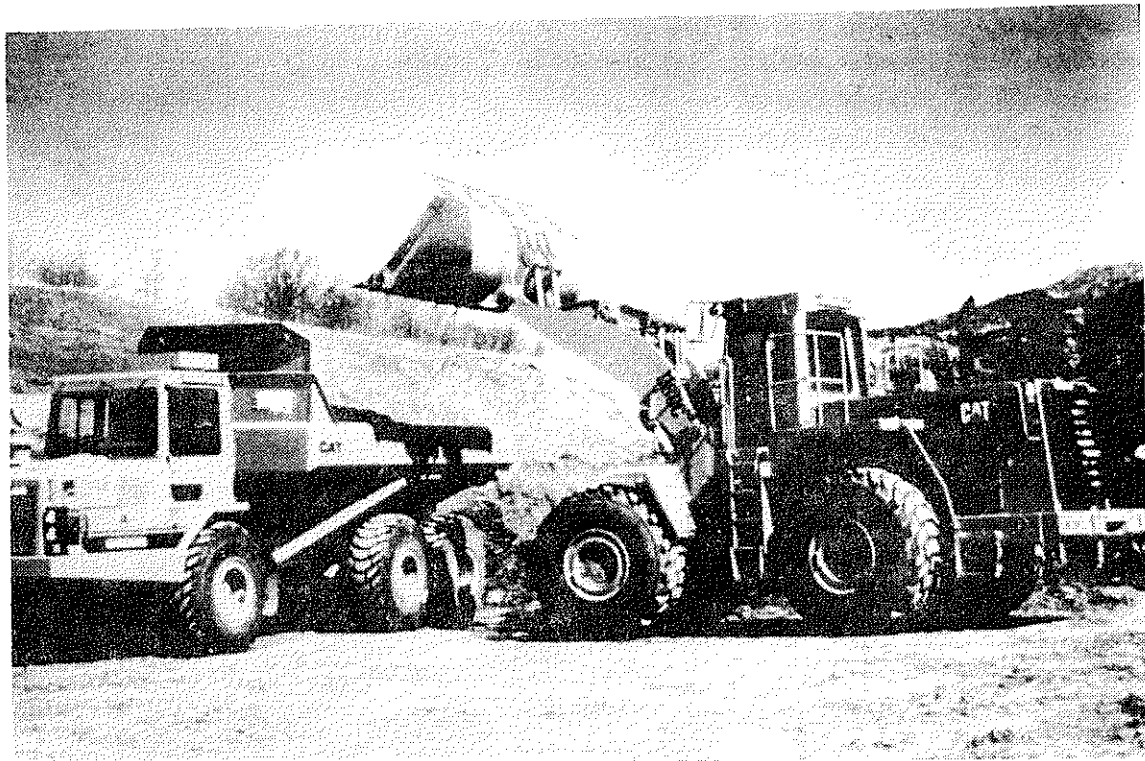
Cargadora Frontal de Llantas cargando camión de volteo
