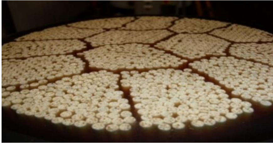
Fuente: Planta de ultrafiltración.
