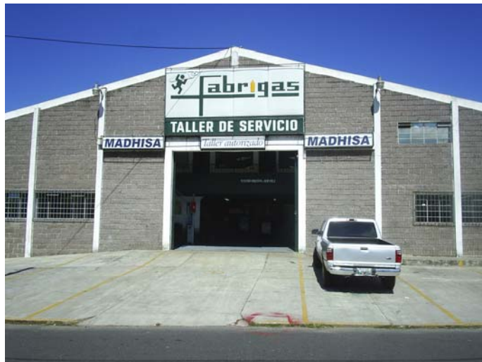
Figura 1. Vista frontal de la edificación
