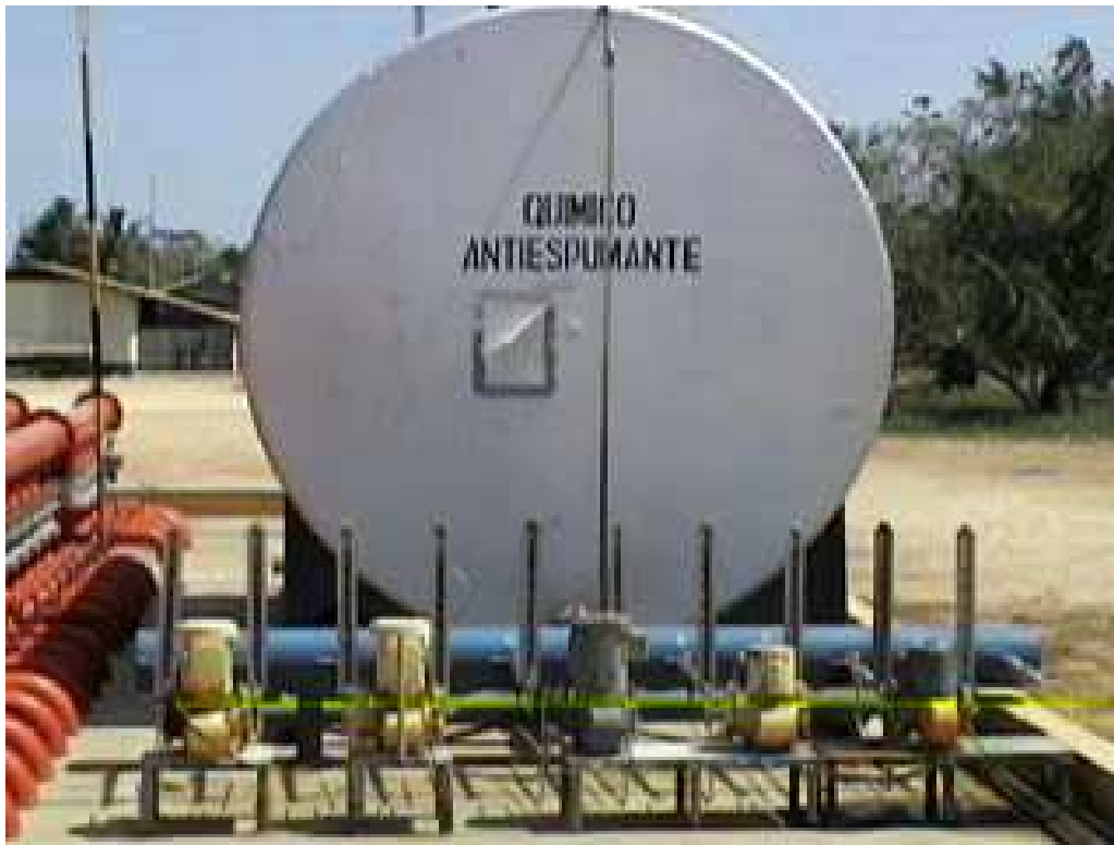
Figura 13. El químico antiespumante es inyectado a la tubería que transporta el crudo antes de ser purificado.
