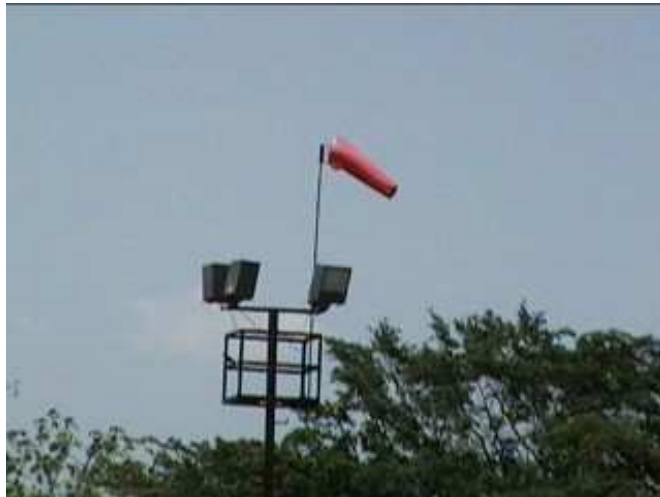
Figura 26. Torre que indica la dirección del viento, deben ser ubicadas a lo largo del campo de producción de petróleo.
