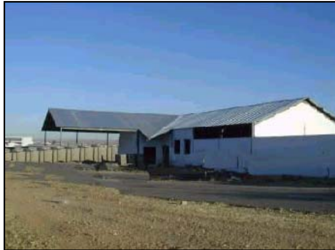
Figura 41. Techo de dos aguas para bodega de procesamiento de madera
