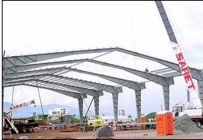
Figura 45. Estructura y columnas de la bodega de procesamiento de cartón.
