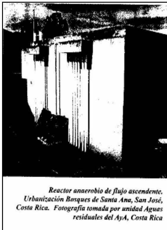
Figura 72. Reactor anaerobio de flujo ascendente o RAFA
