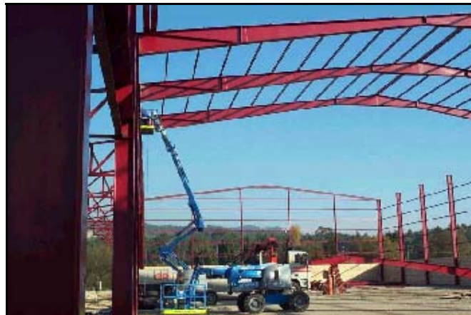
Figura 39. Estructura y columnas de bodega de procesamiento de madera
