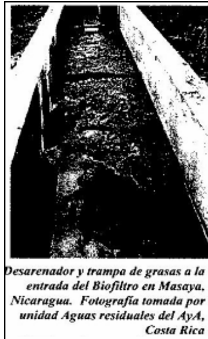
Figura 71. Pretratamiento por medio de trampas de grasa
