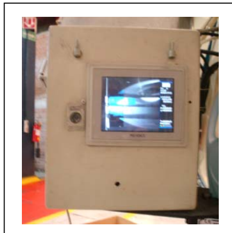
Figura 22. Cámara Keyence del posicionador Posimat
