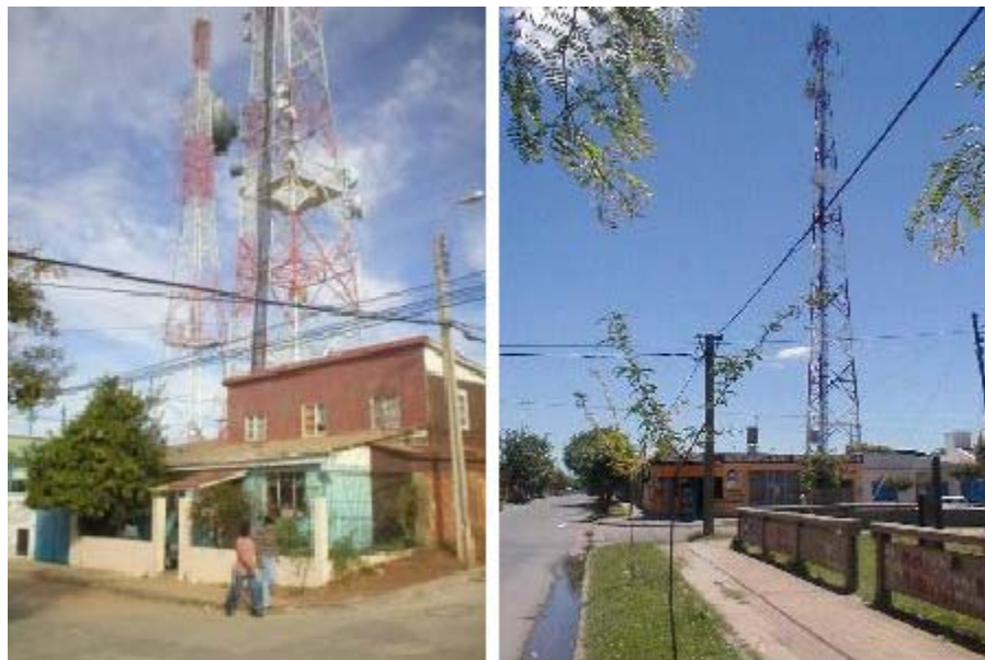
Figura 35. Torres celulares instaladas en zonas urbanas
