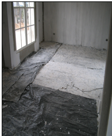
Figura 92. Protección con nylon para la aplicación de textura.
