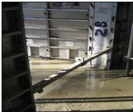
Figura 74. Refuerzo de marco de puerta.
