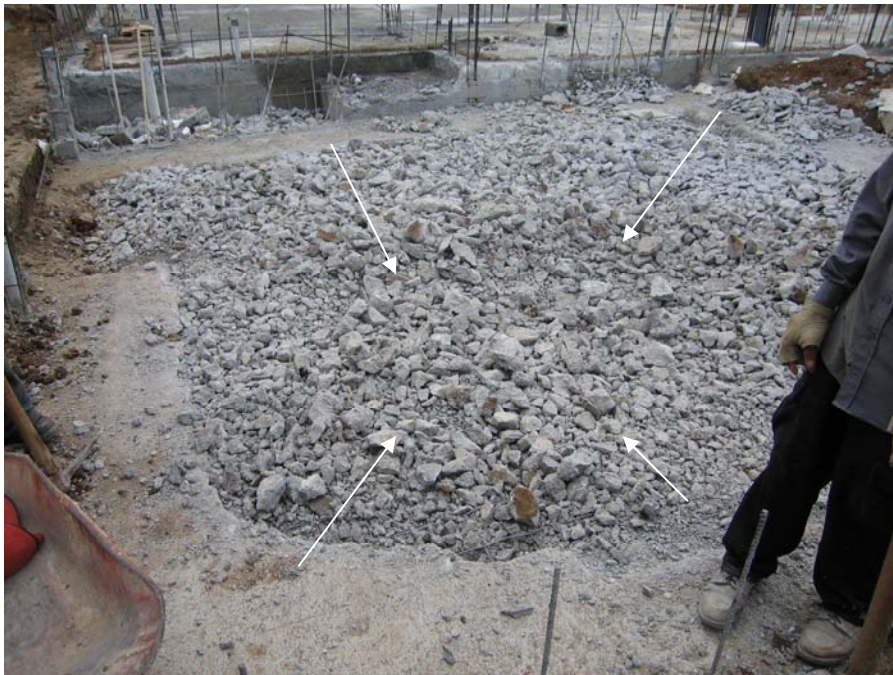
Figura 13. Falta de nivelación con nivel óptico
