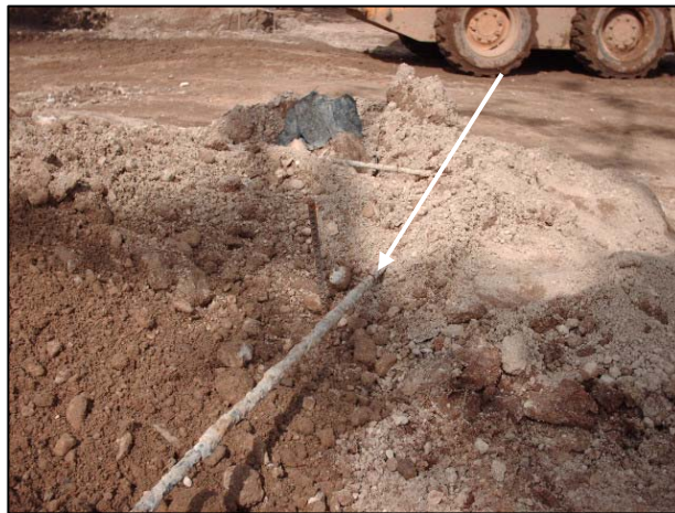
Figura 8. Corral mal puesto
