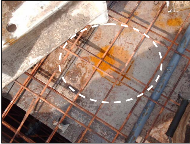
Figura 18. Desperdicio de desmoldante durante la aplicación.
