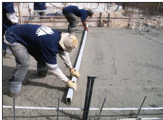
Figura 90. Nivelación del concreto
