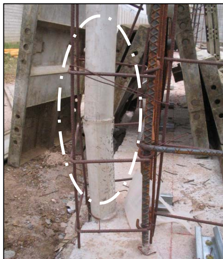
Figura 10. Tubería quemada y de 80 psi
