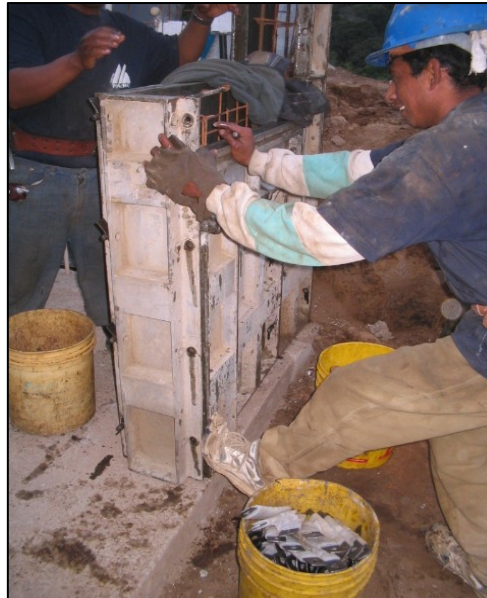
Figura 72. Forma de cerrar un muro.
