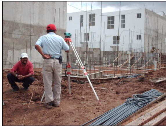
Figura 30. Utilización del nivel óptico
