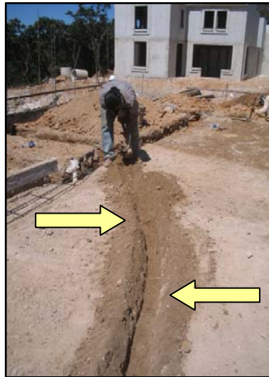
Figura 37. Zanja de dúctos eléctricos e instalaciones especiales
