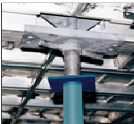
Figura 80. Puntal nivelador.
