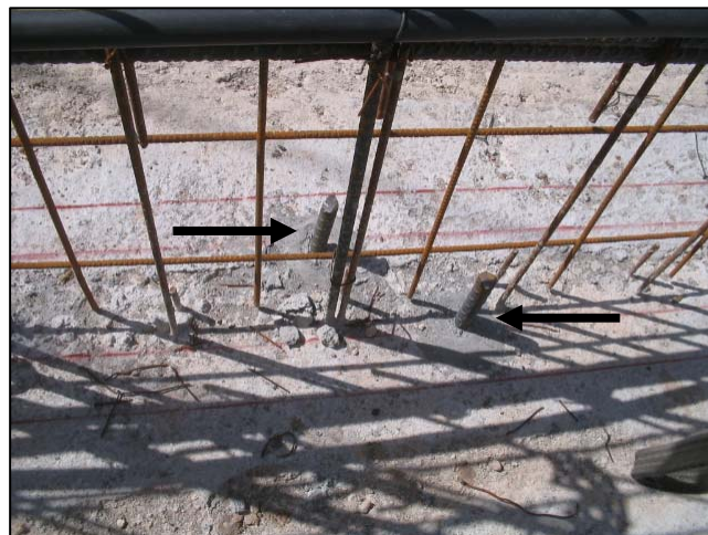
Figura 20. Colocación de pines para topes de formaleta.
