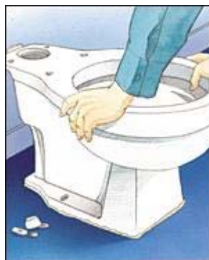
Figura 99. Colocación del inodoro sobre su base
