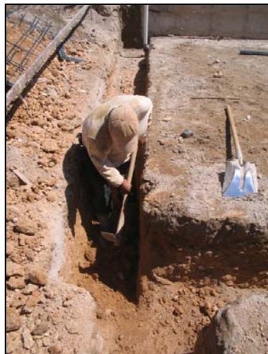
Figura 36. Zanja de drenaje sanitario y agua pluvial.
