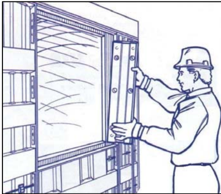
Figura 73. Colocación de pin grapa
