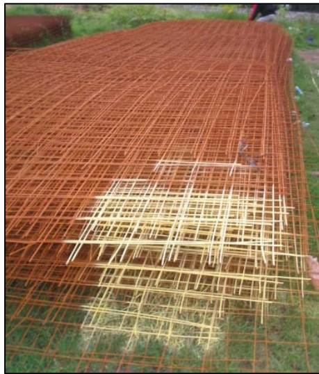
Figura 61. Pintado de electromalla según el uso
