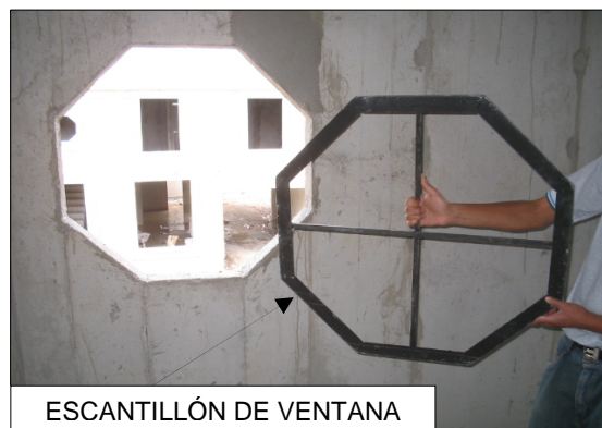
Figura 51. Escantillón para verificación de vanos
