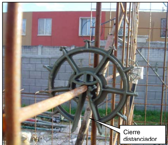
Figura 65. Posición de distanciador
