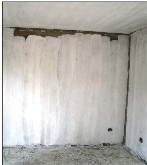
Figura 93. Fondo aplicado en muros y techo.
