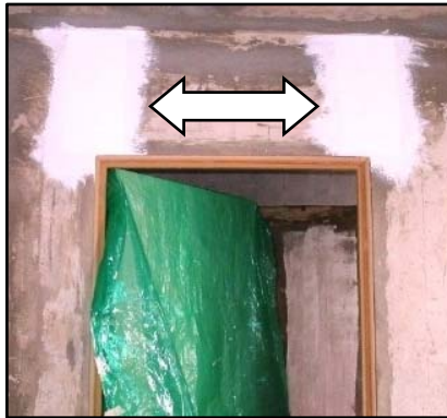
Figura 91. Tela de doble refuerzo.
