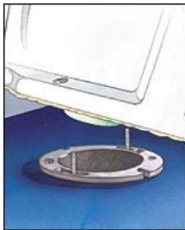
Figura 98. Encajar en las perforaciones de la base del inodoro
