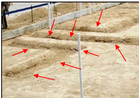
Figura 38. Zanja de cimiento corrido
