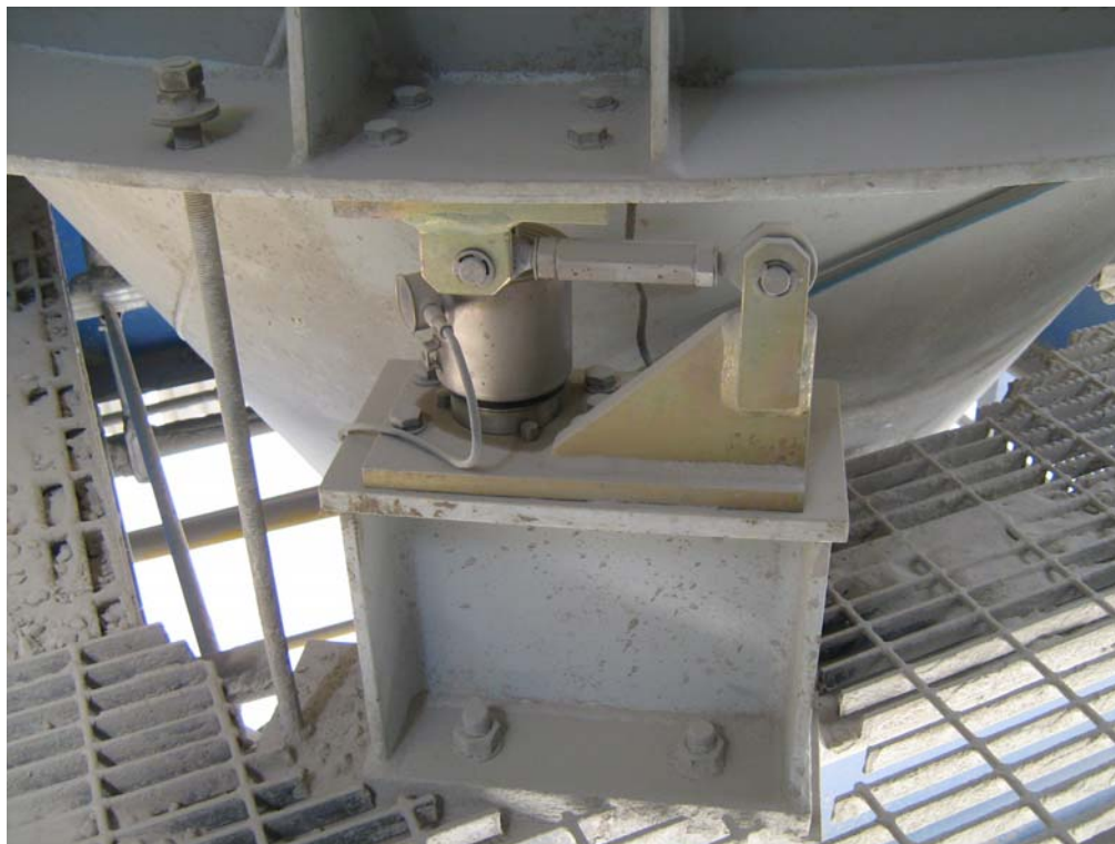
Figura 14. Mantenimiento a celdas de carga
