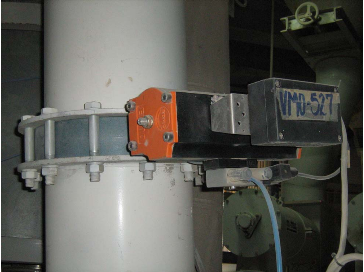
Figura 15. Válvulas de mariposa de descarga de báscula.
