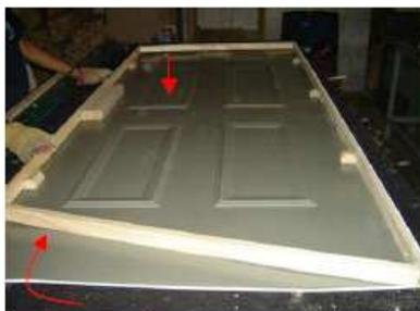
6. Por ultimo se coloca la otra lamina, haciéndola que case en los lados de la pilastría.
