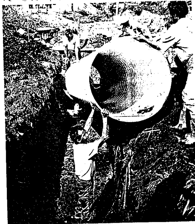
FACIL MANIOBRA EN LA OBRA
