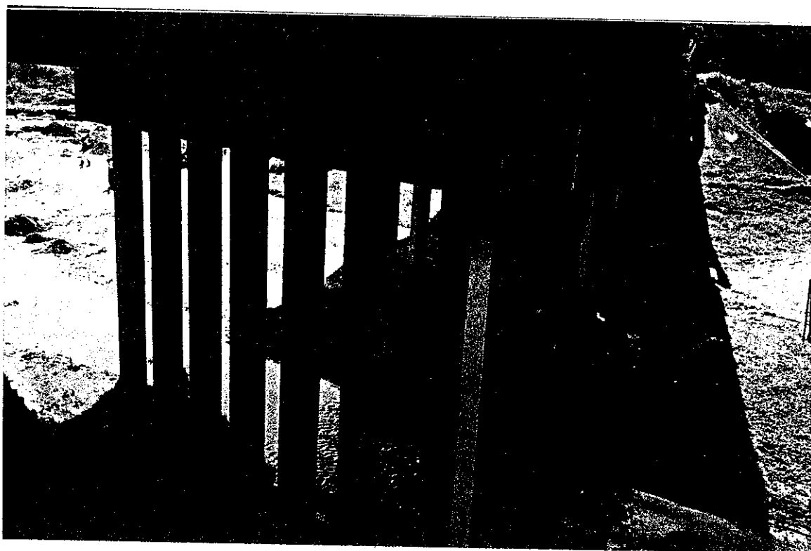
Fotografía No.2 Subestructura del puente
