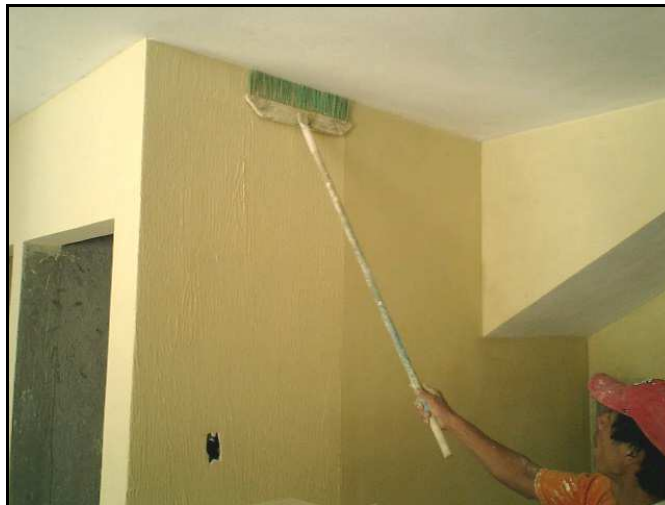
Figura 6. Casa en fase de acabados
