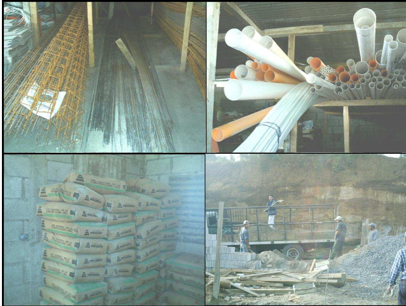
Figura 7. Materiales para fase de obra gris
