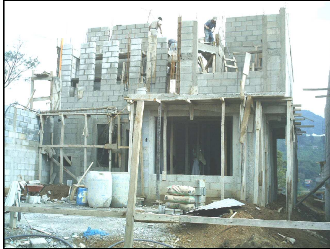
Figura 5. Casa en fase de construcción de obra gris
