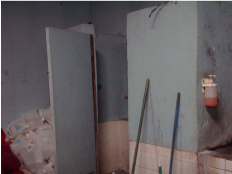
Figura 25. Área de lavado de trapeadores, trapos, etc.
