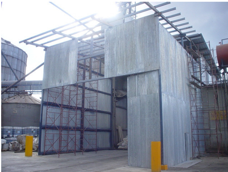
Figura 83: Vista lateral de la 3era. fase del proyecto, contención de polvos.
