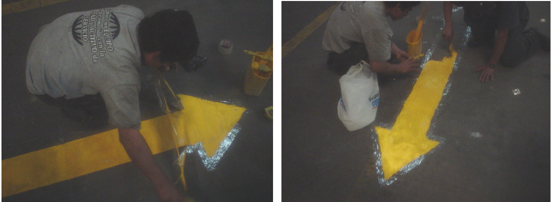
Figura 48 & 49: Elaboración de señales para paso de montacargas.
