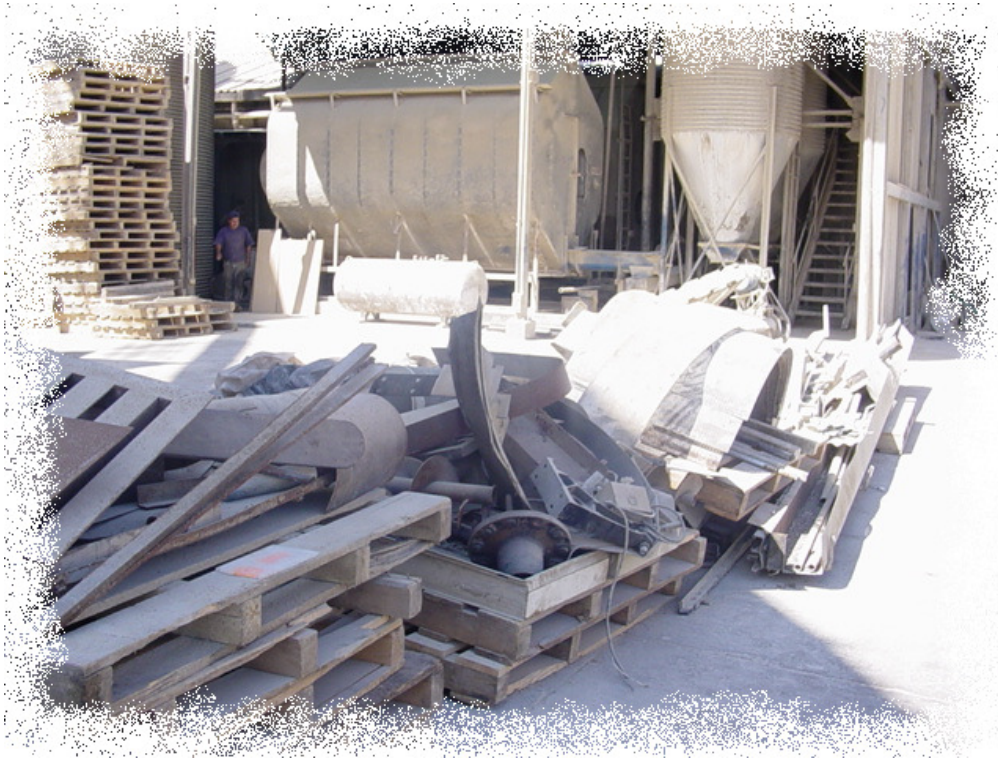
Figura 10: Tolva de descarga norte
