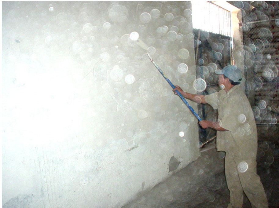
Figura 62: Reacondicionamiento y limpieza de las instalaciones, SEISO (2).
