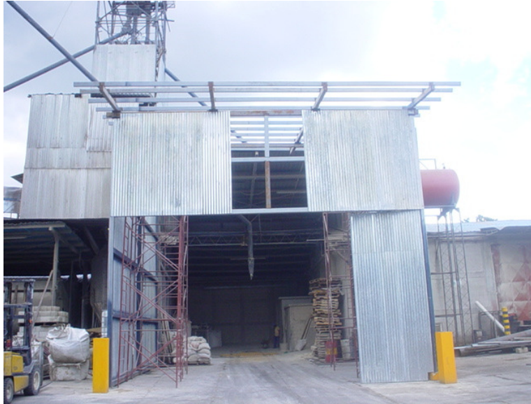
Figura 80: Vista frontal de la 2da. fase del proyecto, contención de polvos.
