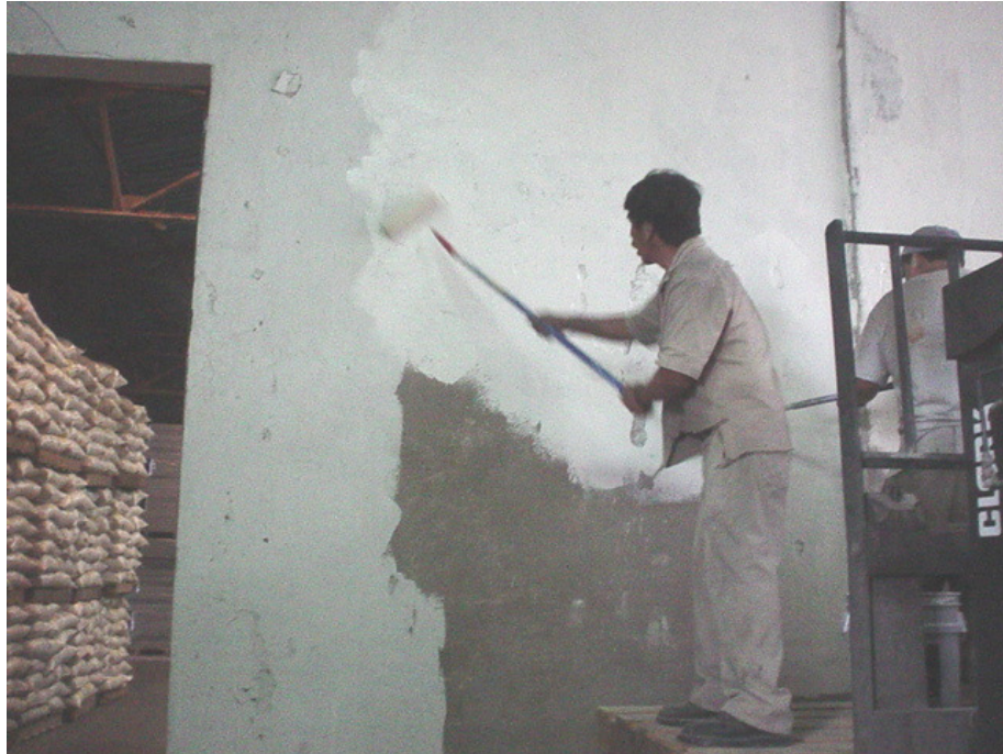
Figura 61: Reacondicionamiento y limpieza de las instalaciones, SEISO.
