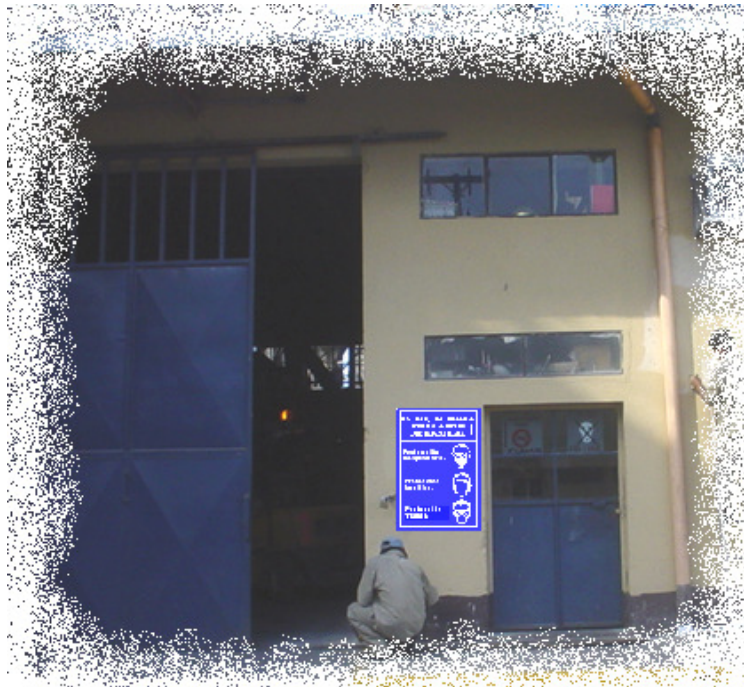
Figura 42: Señalización área de pre-mezcla.
