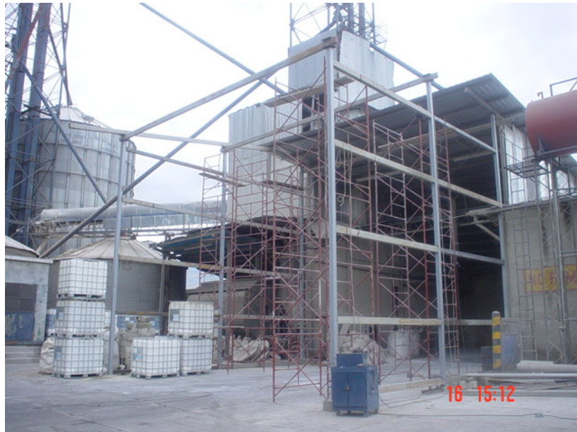
Figura 79: Vista lateral de la 1era. fase del proyecto, contención de polvos.
