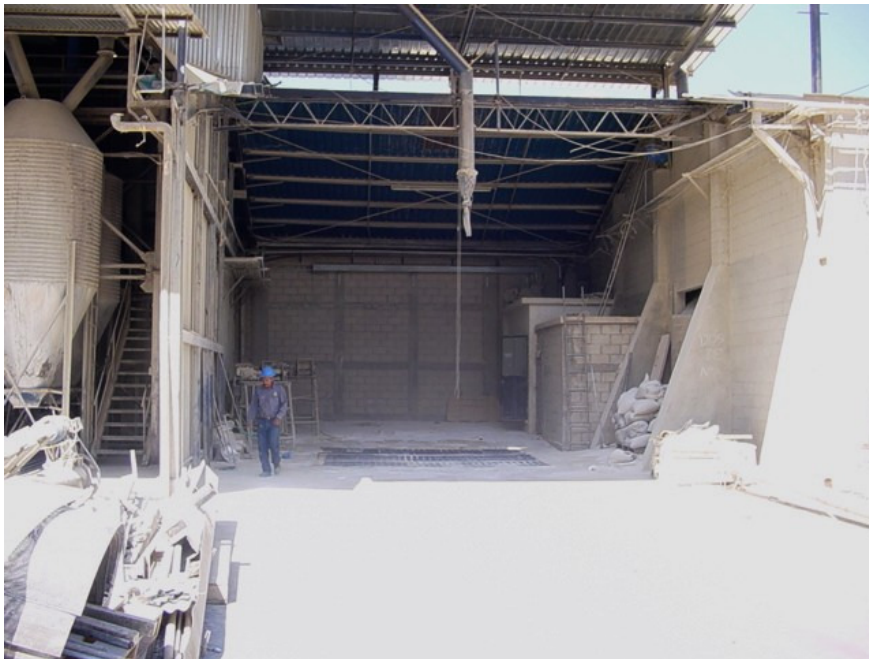
Figura 35: Tolva de descarga norte.
