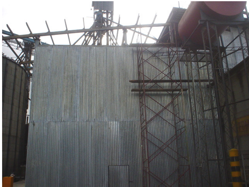
Figura 82: Vista lateral de la 2da. fase del proyecto, contención de polvos.
